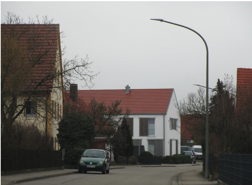
Die moderne giebelständige Neubebauung Schulstraße 4/4a im Hintergrund fügt sich mit ihren Kubaturen und ihrem roten Satteldach ins Straßenbild ein, zudem wurde die verdeckt dahinterliegende Scheune erhalten (Foto: Stadt Land Fritz 2023)
